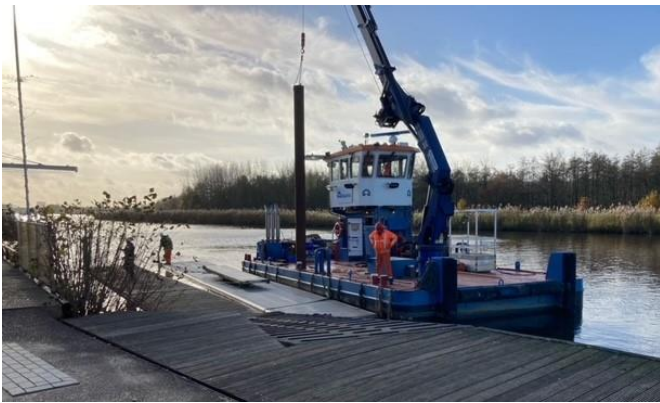
Werk in uitvoering ter hoogte van het Bredavlot
